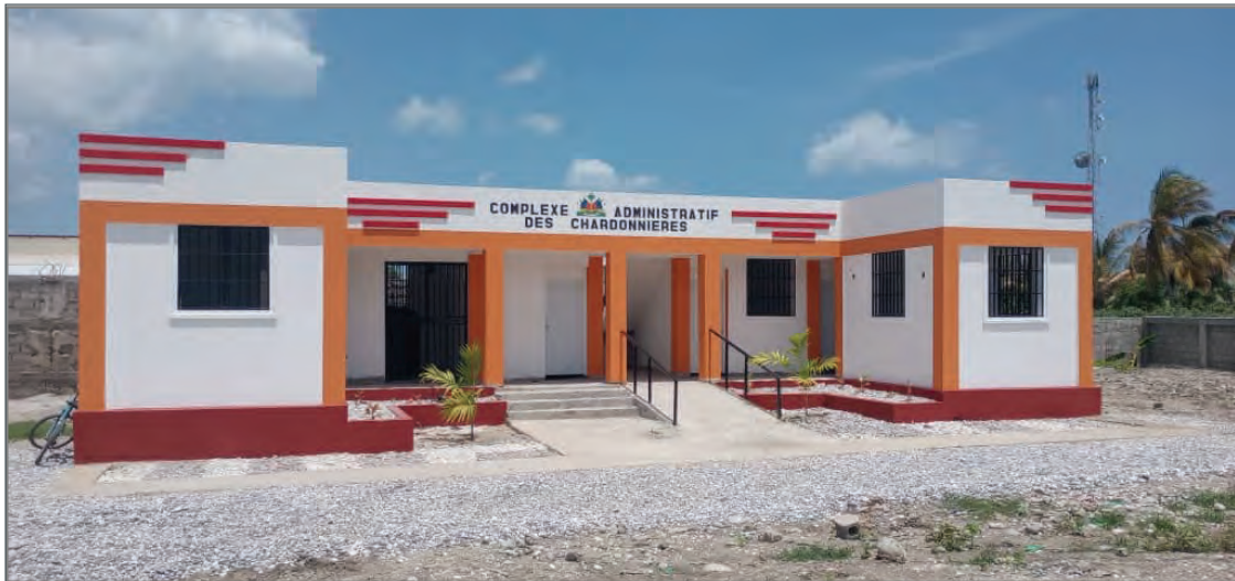
Le nouveau bâtiment de la Mairie de Chardonnières (détruite par le séisme d'août 2021), priorisé et reconstruit par les acteurs communaux en 2022-23 dans le cadre du dispositif FIL.
