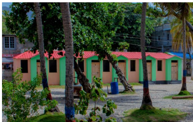
Ci-dessus, travaux d'aménagement de ravine à Tiburon (Sud) et aménagement de la plage de Raymond-les-Bains (Sud-Est), 2023.
