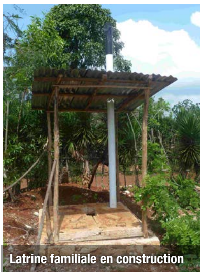
Construction d'une ossature de latrines en bois selon des savoir-faire locaux
