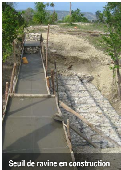
Construction de seuils de ravines maçonnés pour créer des terres cultivables
