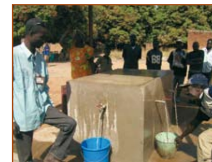
Une des bornes fontaine reliée au château d'eau à Doumbeur
